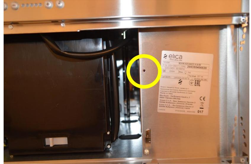
Remove the grease filter and remove the screws at left and right side / Togliere il filtro grassi e svitare le viti fissaggio a destra e sinistra
