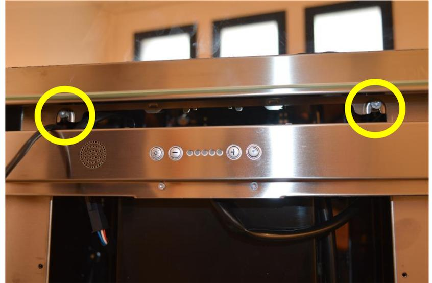
Unhinge the frame from the motor housing / sganciare il telaio filtro dal box motore
