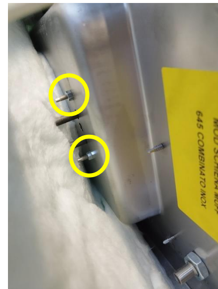
Remove electrical connection, unscrew the fixing screws of upper heating element / Togliere collegamento elettrico, svitare le viti di fissaggio resistenza
