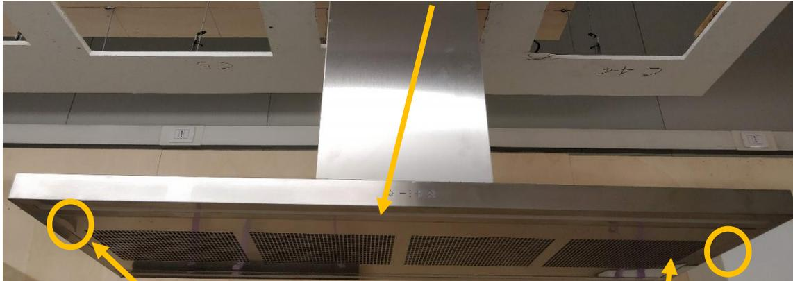
Push and pull to open the grease filter panel / premere e tirare per aprire il pannello con i filtri grassi
