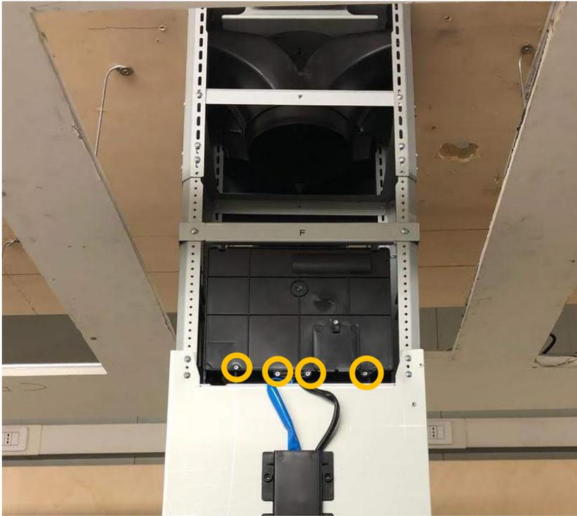
Unscrew n. 4 screws to open the plastic box / rimuovere 4 viti per aprire la scatola in plastica
