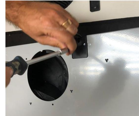
In order to get access with power input unistall the hood from the cabinet, remove one frontal screw, all rearward screws and 2 screws of the power input support / Per accedere all'alimentatore disinstallare la cappa dal pensile, rimuovere la vite frontale, rimuovere tutte le viti sulla parte posteriore e rimuovere le 2 viti del supporto dell'alimentatore.
