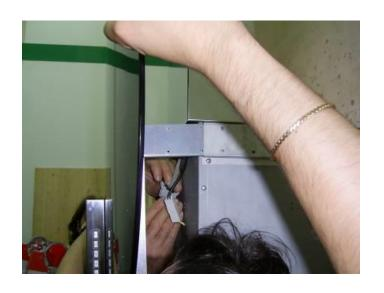
Fix the chimney with the bracket on to the wall. Place the glass front panel in to the fixing guides and complete the electrical connection of controls and lamps / Fissare il caminocon la staffa al muro. Posizionare il pannello frontale in vetro nelle guide di fissaggio e completare il collegamento elettrico dei comandi e delle lampade
