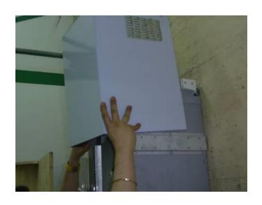
Secure the hood with the lower fixing screws. Place on top the esthetical duct, the minimum extension is given by the bracket / Fissare la cappa con le viti di fissaggio inferiori. Posizionare sopra il condotto estetico, l'estensione minima è data dalla staffa.
