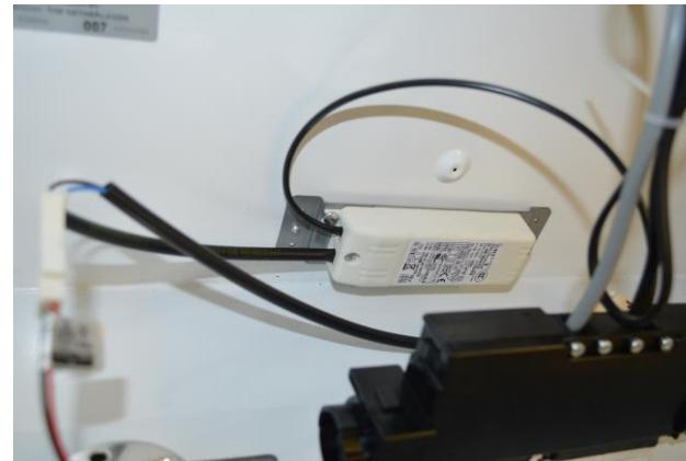
In case of electronic valve, disconnect wirings and open electronic box removing all screws / In caso di valvola elettronica disconnettere i cablaggi e aprire la scatola elettronica rimuovendo le viti
