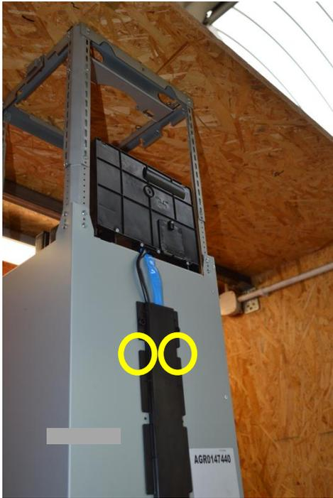
Remove the 2 fixing screws, push upwards the sleeve protection and unhinge it / Rimuovere le 2 viti di fissaggio, spingere verso l'alto la protezione della guaina e sganciarla
