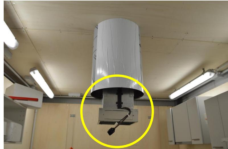
Fix the UPPER part of the hood to the structure with all screws / Fissare il tubo superiore alla struttura con tutte le viti
