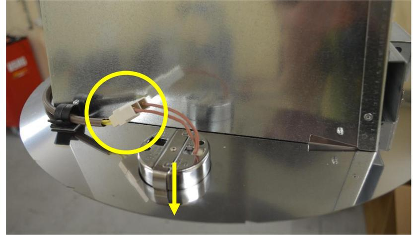
Use any kind of support to keep it in up position. Disconnect lamp connector and press lateral metal spring and pull down the lamp / Utilizzare qualsiasi tipo di supporto per mantenerlo in posizione. Scollegare il connettore della lampada e premere la molla metallica laterale e tirare verso il basso la lampada
