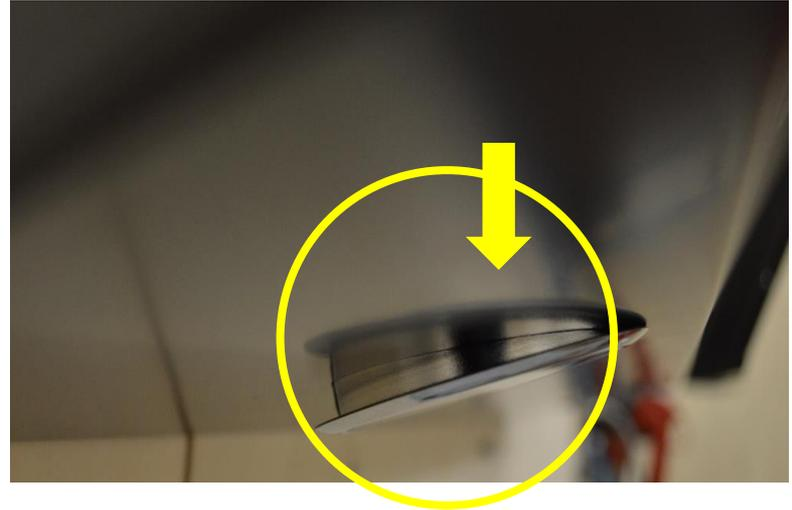
Disconnect the lamp connection, press the lateral lamp springs and push the lamp down to remove it / Disconnettere le connessioni delle lampade, premere le molle delle lampade lateralmente e spingere la lampada fuori dalla sua sede
