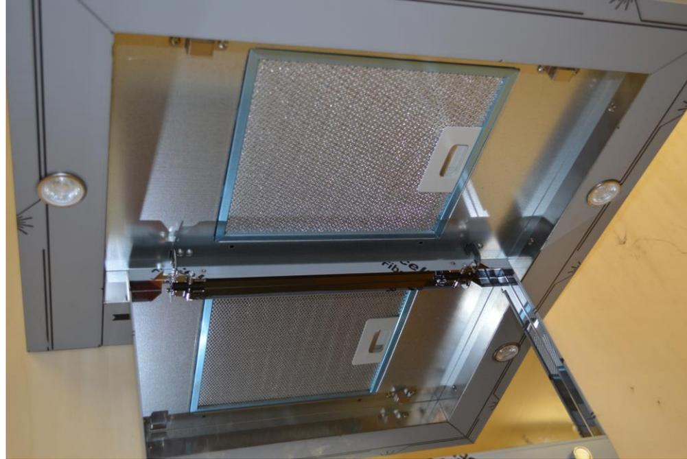
Remove edge extraction panel and grease filter / rimuovere il pannello perimetrale e le griglie filtro
