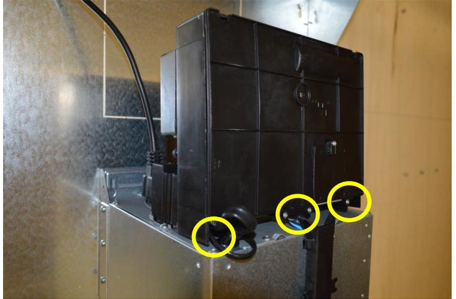
Remove the 4 fixing screws from electronic device cover / Rimuovere le 4 viti di fissaggio dal coperchio del dispositivo elettronico
