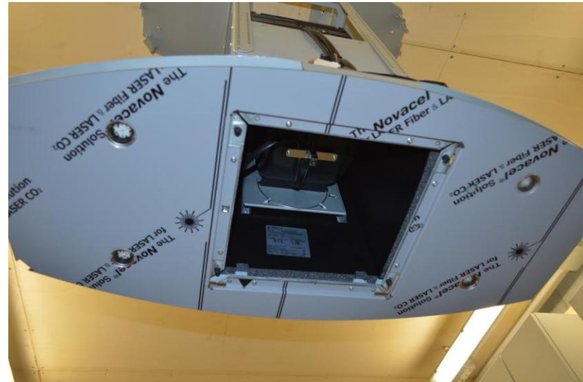
In order to remove filter, rotate 2 rings / ruotare i 2 anelli per sganciare il filtro
