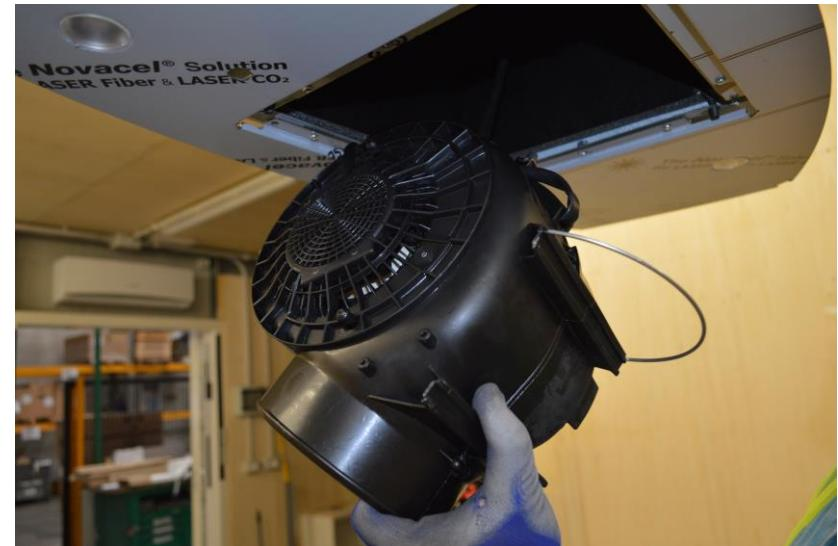
Use screwdriver and hold on the complete conveyor / Usare un giravite e tenere il convogliatore completo per non farlo cadere
